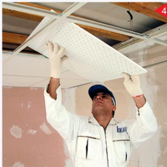
پس از اجرای شبکه، تایل های مورد نظر در داخل شبکه ها قرار داده می شود
