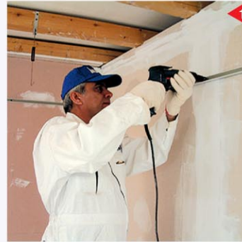
نصب سازه نبشی تراز سقف
