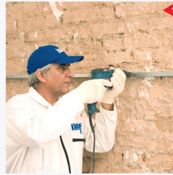
نصب سازه نبشی تراز سقف
