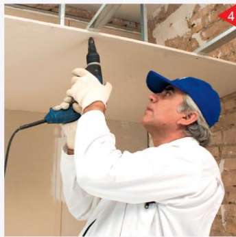
نصب صفحات به سازه
