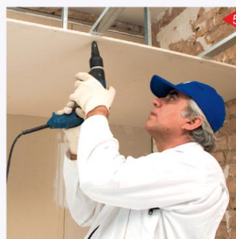
نصب صفحات به سازه
