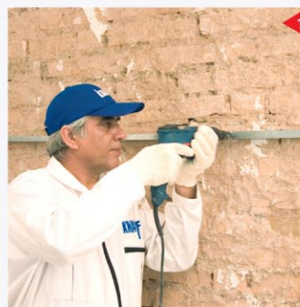
نصب سازه نبشی تراز سقف
