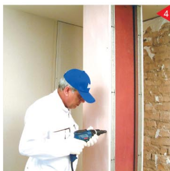
نصب صفحات بر روی سازه فلزی
