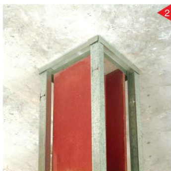
قرار دادن سازه های استاد C در رانر کف و سقف
