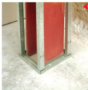
اجرای رانر کف
